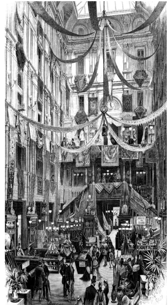
Magazzini "La Rinascente"
